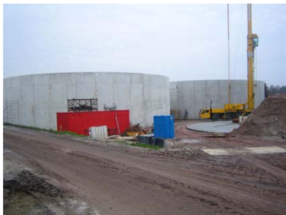
Figuur 4.2: Vergister in aanbouw
