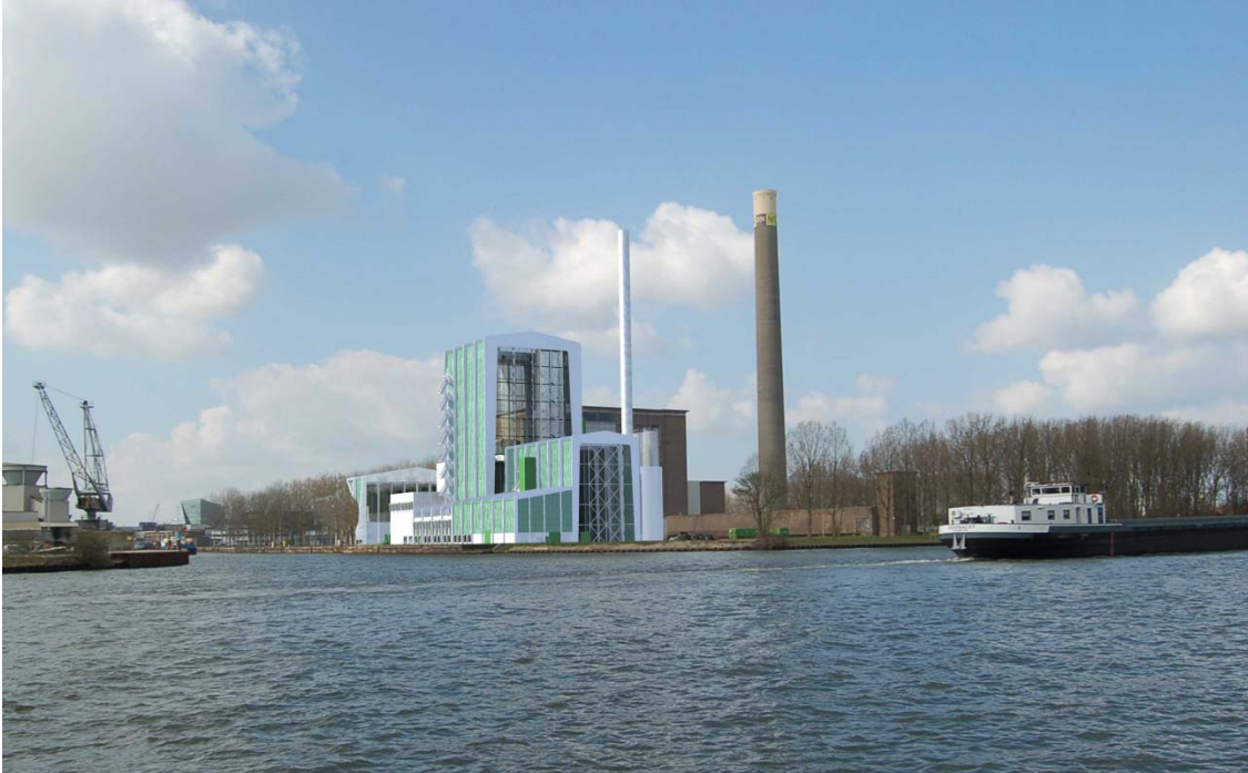
Afbeelding 7: Impressie biomassa energiecentrale Groene Weide
