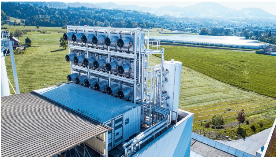
Figure 11.1 De eerste commerciële fabriek bij Zürich die sinds mei 2017 CO 2 uit de buitenlucht haalt. Iedere unit haalt 50 ton CO 2 per jaar uit de atmosfeer. Bron: (Brugh 2017)
