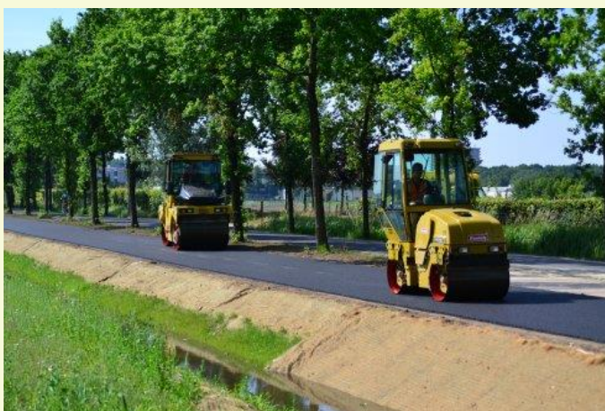
Biomassa wordt in toenemende mate benut voor biobased toepassingen. In Wageningen is in 2017 een fietspad aangelegd van bio-asfalt, waarbij een deel van de bitumen is vervangen door lignine uit hout (foto Wageningen UR).
