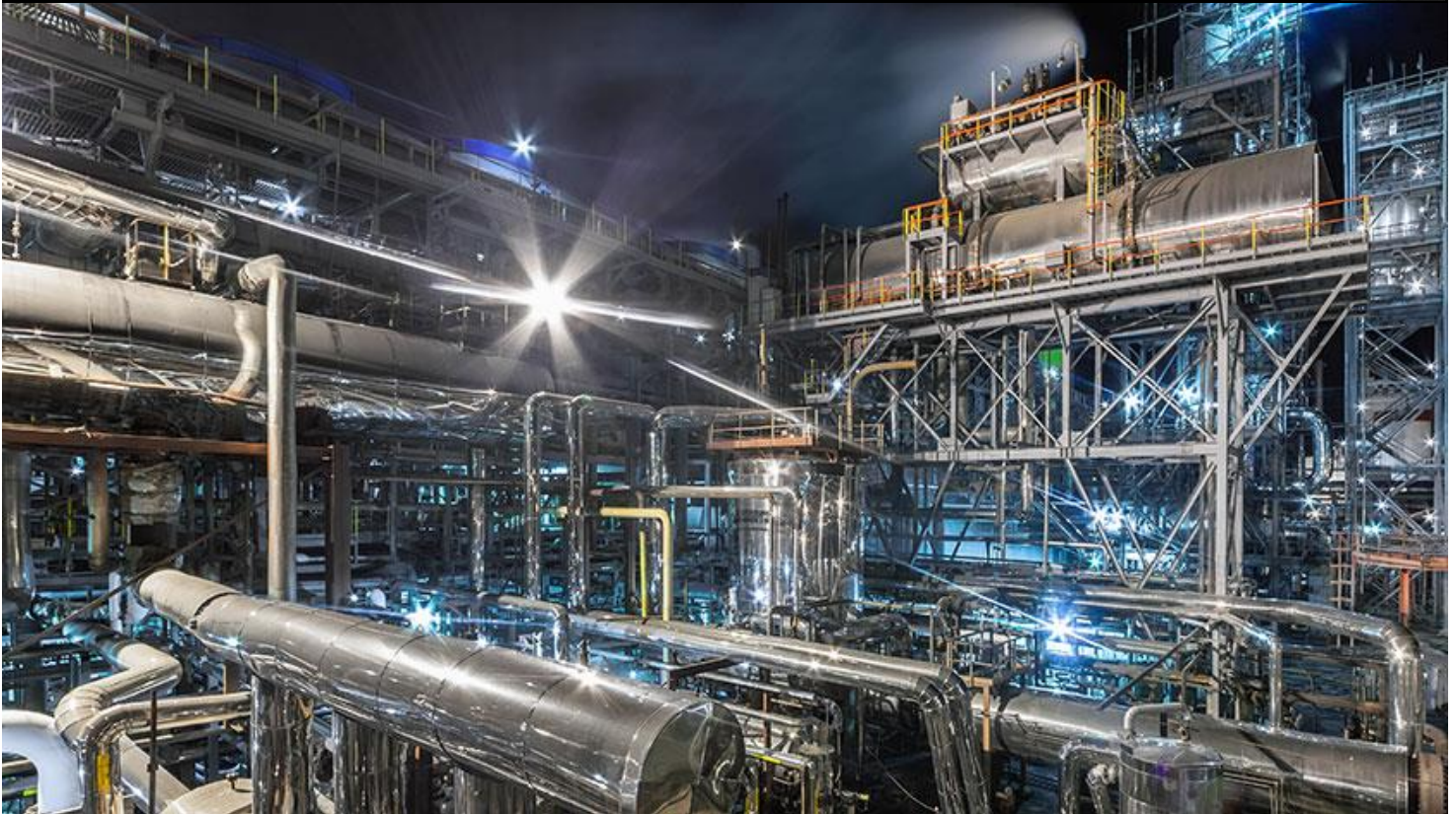
Afbeelding 3: Carbon Capture Storage installation
