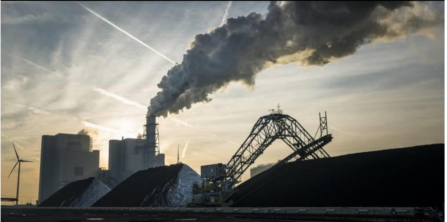
Afbeelding 4: RWE (Essent) kolen/biomassacentrale in de Eemshaven
