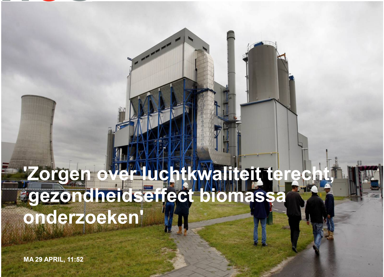
DE BIOMASSACENTRALE IN MOERDIJK ANP
