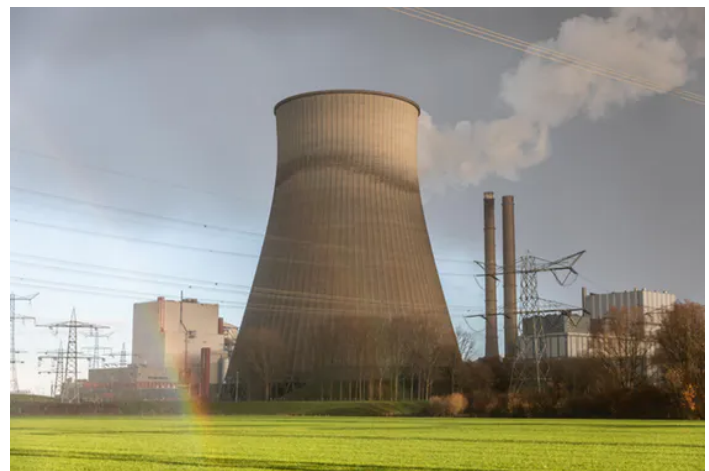
De Amer-centrale van RWE in Geertruidenberg. (Bron: Rias Immink/HH)
